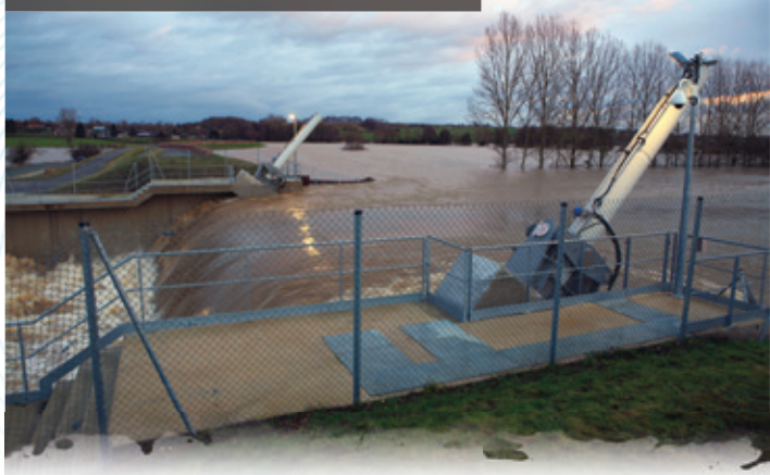
L'ouvrage de Proisy activé lors de la crue en 2011
