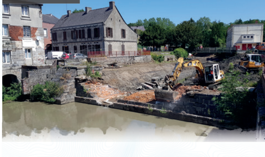
Démolition du seuil Pasteur
